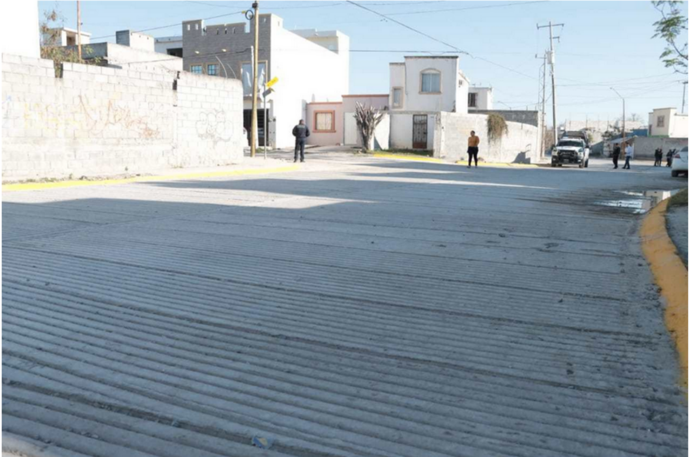
Aplican concreto hidráulico en vialidades de Juárez. Foto: Cortesía
